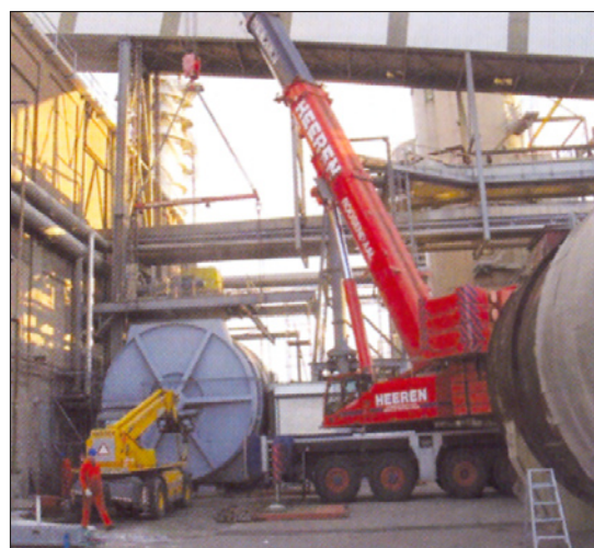
شکل شماره ۹: تعویض مایشه خلال چغندر در حین بهره‌برداری
